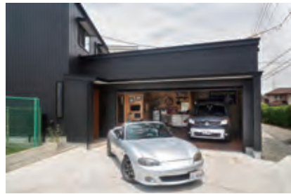
2台の車両を格納するガレージには換気扇も設置。 厳冬期にガレージ内で暖気運転することも可能だ。
