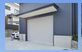
ガレージのシャッターは三和シヤッター製軽量電動式シャッター 静々動々を導入。アルミ製で光電センサがついている。シャッ ター上には庇がついて雨の日の対策としている。
